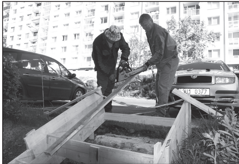
Jako první ze schodišť se letos dočká opravy to v ulici Karla Marxe. Na snímku z poloviny května pracovníci firmy Stavan Petr Pilný a Zdeněk Ivančík při přípravě prken pro bednění nových schodů. Foto Luboš Mizun
