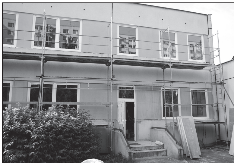
Výměna oken ve školce ve Školní ulici proběhla v červenci. Foto ED
